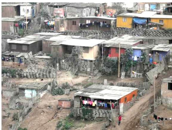
Fig. 1. Viviendas en laderas de San Juan de Miraflores.
